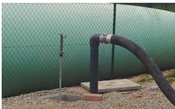
Exemple : 1 prise de 100 mm de diamètre pour 1 colonne fixe d'aspiration de 100 mm de diamètre.
